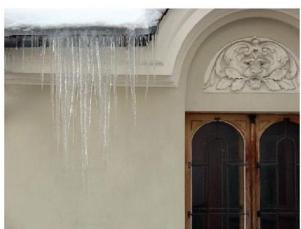
Вы можете наблюдать потери энергии через крышу, даже если на ней лежит немного снега - он интенсивно тает там, где уходит тепло. Чаще всего, так называемые «мостики холода» в здании образуются на стыках: между панелью стены и балконной плитой, между стеной и полом, стеной и крышей, а также в других местах, где есть разрыв между материалами и поверхностью конструкций. Технология помогает предотвратить образование «мостиков холода».
